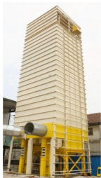
烘干机组装现场图
